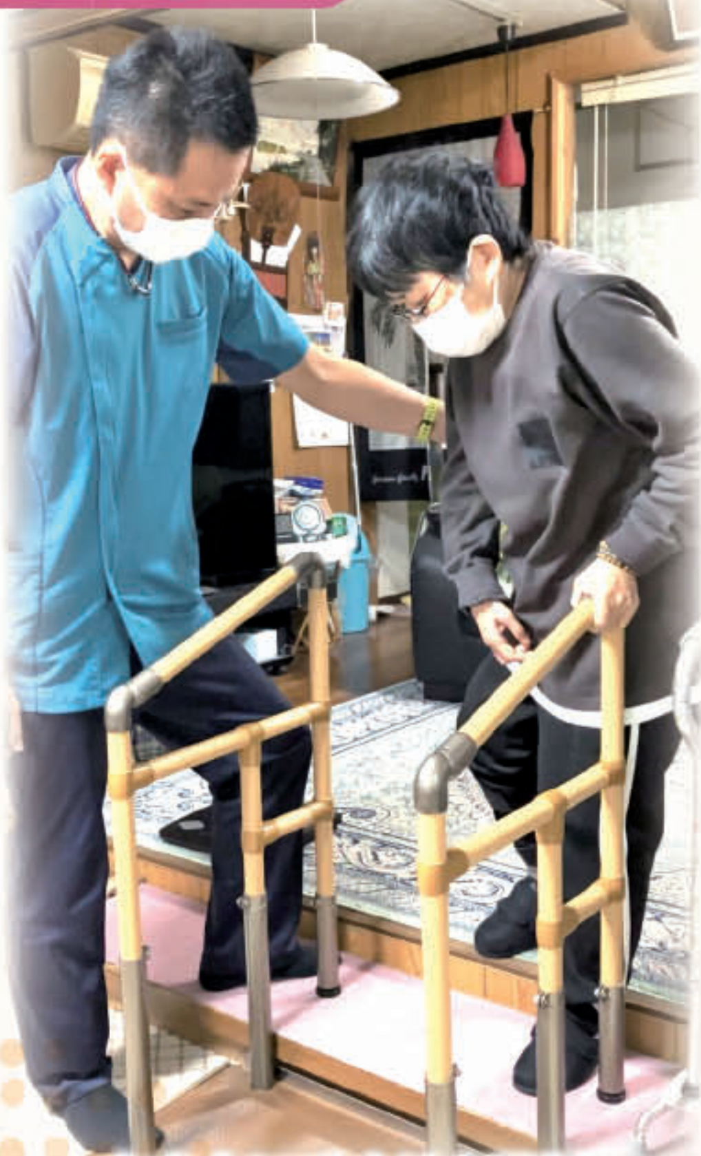
自宅内に手すりを設置
